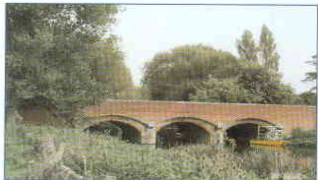
MIDDLE BRIDGE - NEWPORT PAGNELL
