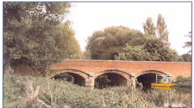
MIDDLE BRIDGE - NEWPORT PAGNELL
